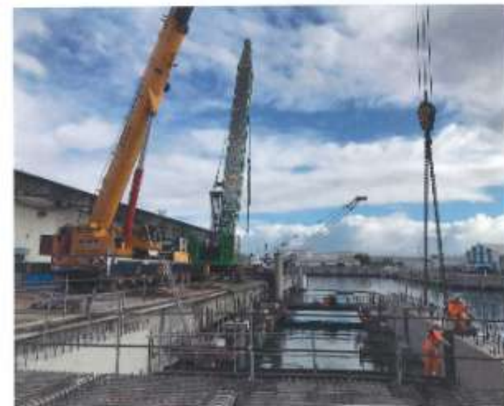
Mise en place des poutres longitudinales.
