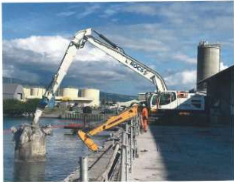
Démolition des piles.
