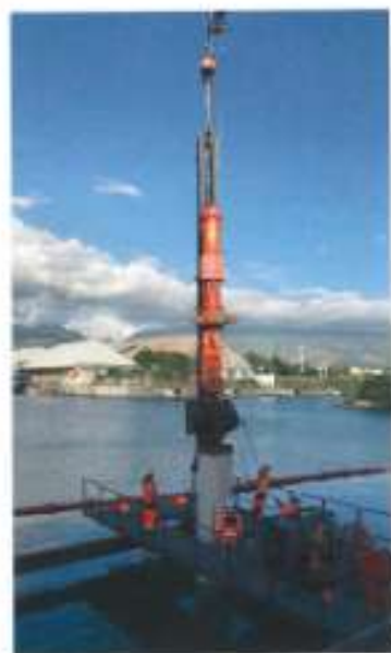
Phase de battage des pieux.
