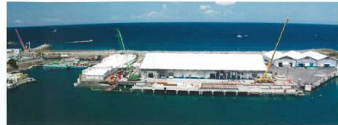
Le quai du poste n°1 est situé sur la façade ouest de l'île de La Réunion.
