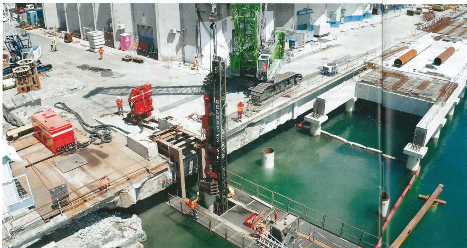
Équipée d'une flèche de 35 m, la pelle à câbles 6140 HD de Sennebogen offre des capacités de levage de 17 t et une portée de 24 m.
